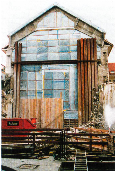
Bild 7. Abdichtungsmassnahmen beim KW Gösgen zum Schutze der in Betrieb stehenden Maschinen.
