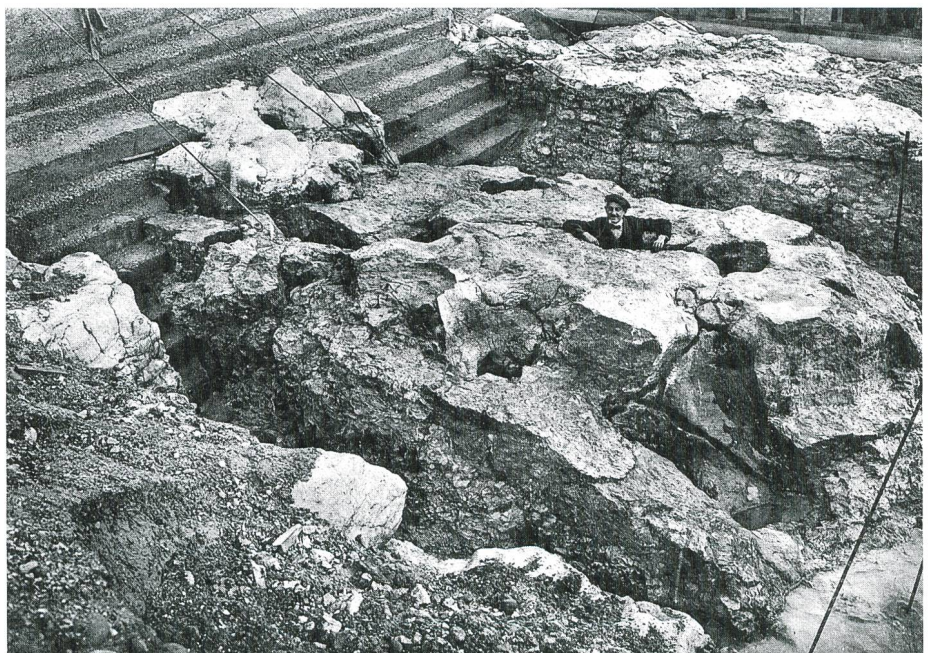
Bild 6. Felsuntergrund des KW Gösgen während der Bauzeit.
