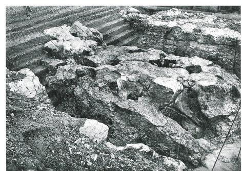
Bild 6. Felsuntergrund des KW Gösgen während der Bauzeit.
