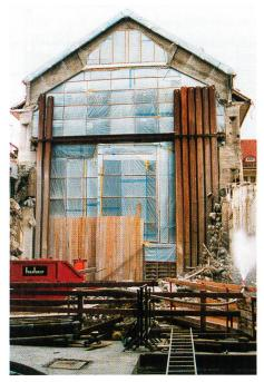
Bild 7. Abdichtungsmassnahmen beim KW Gösgen zum Schutze der in Betrieb stehenden Maschinen.
