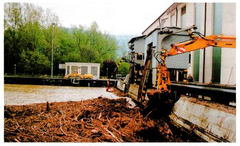
Bild 1. Geschwemmselteppich vor dem Turbineneinlauf eines Flusskraftwerks.
