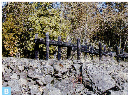
Figure 3. Exemple de structures destinées à piéger le bois et limiter son déplacement aval ou au sein du lit majeur. A. pieux installés dans un lit d'inondation localisé dans une section concave, prairial, surbaissé, qui sont destinés à retenir les bois avant qu'ils ne traversent la section urbaine de Bourgoin Jallieu (France). B. Barrière de bois réalisée sur la rivière Willamette (amont de Corvallis, Orégon), surmontant une protection de berge en enrochement et destinée à piéger les corps flottants avant qu'ils ne pénètrent dans des plantations forestières localisées en zone inondable.
