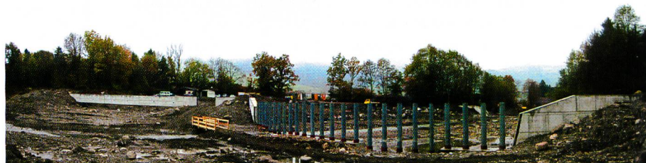
Bild 5. Kombierter Holz- und Geschieberückhalt mit Rechen und Tauchwand an der Gürbe bei Wattenwil (oben: Modell, unten: realisiertes Projekt).
