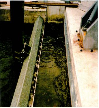
Bild 2. Rechenreinigungsanlage zur Entnahme von Geschwemmsel.
