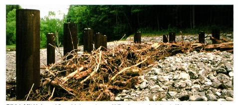
Bild 4. Mit Holz und Geschiebe verlegter V-Rechen am Lainbach (Oberbayern) nach einem Hochwasser; Blick in Fliessrichtung (Foto: Versuchsanstalt für Wasserbau und Wasserwirtschaft der TU München, Obernach).
