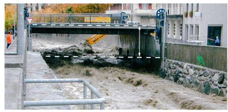
Bild 2. Entschärfung eines kritischen Querschnitts durch Anheben der Brücke im Hochwasserfall; Hubbrücke an der Saltina in Brig-Glis während des Hochwassers vom Oktober 2000 (Foto: A. Burkard, Brig-Glis).
