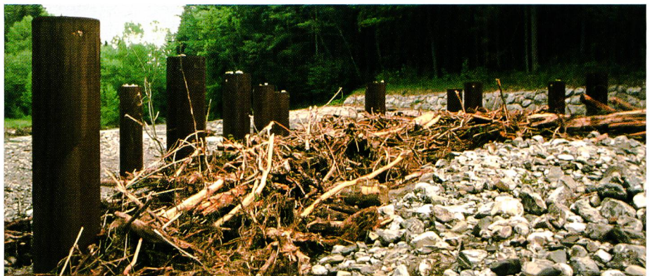
Bild 4. Mit Holz und Geschiebe verlegter V-Rechen am Lainbach (Oberbayern) nach einem Hochwasser; Blick in Fliessrichtung (Foto: Versuchsanstalt für Wasserbau und Wasserwirtschaft der TU München, Obernach).
