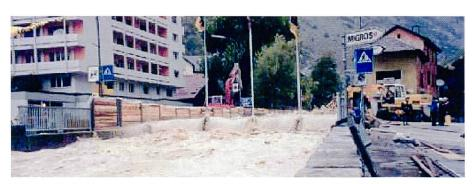
Bild 11. Die im Sommer 2000 realisierten Sofortmassnahmen (überflutbare Brücke mittels seitlicher Dammbalken) verhinderten am 15. Oktober 2000 einen Ausbruch der Lonza im Bereich des Gefällsknickes in die Dörfer Gampel und Steg.
