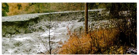
Bild 13. Beispiele von Ufererosionen der Val Mulin (Kanton Graubünden) vom 15. bis 17. November 2002 im Bereich des bewaldeten Kegelhalses (oben) und im neuen Bachbett auf dem Wildbachkegel (unten).
