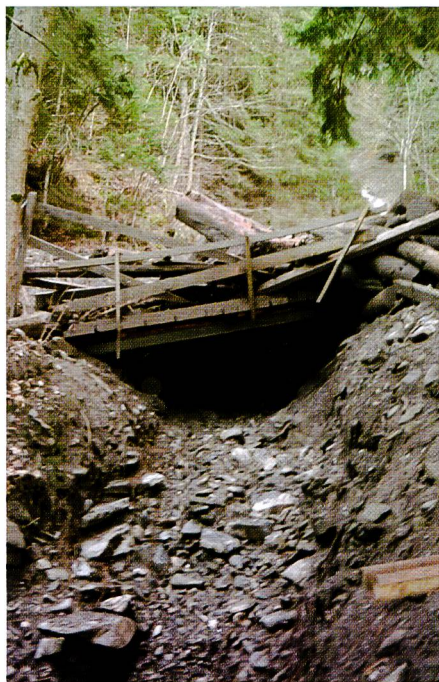
Bild 14. Beim Ereignis vom 15. bis 17. November 2002 verklausten zahlreiche Brücken über Wildbäche in den Emser Maiensässen, teilweise nur durch Geschiebe (links) oder durch Holz und Geschiebe (rechts).
