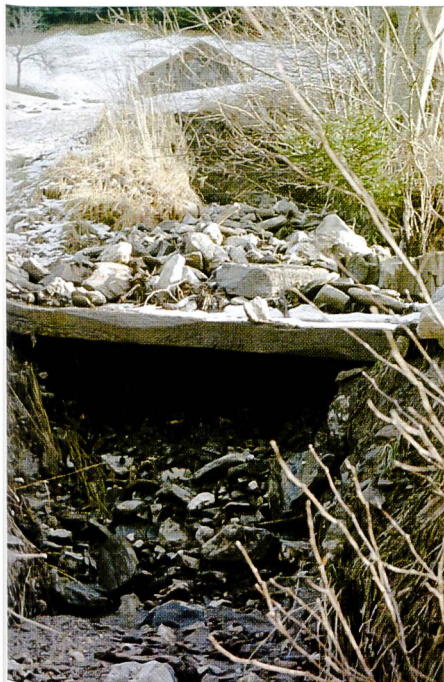
Bild 14. Beim Ereignis vom 15. bis 17. November 2002 verklausten zahlreiche Brücken über Wildbäche in den Emser Maiensässen, teilweise nur durch Geschiebe (links) oder durch Holz und Geschiebe (rechts).
