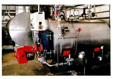
Bild 1. Der Biogaskessel wandelt das energiereiche Methan um, das als Nebenprodukt bei der Abwasser-Aufbereitung im BIOMAR®AFB Reaktor freigesetzt wird.
