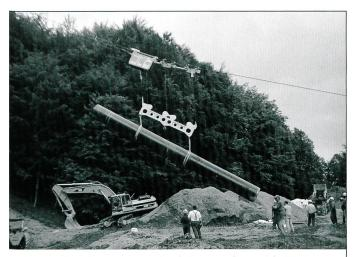
Transport und Versetzen Erdgasleitung, Rohrgewicht 12 Tonnen
