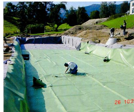
**Bild 1. Kostengünstige Regenwasserspeicherung in einem unterirdisch angelegten Retentionsbecken: Mit dem neuen Nidaplast-Sarnafil-System ist beliebiges Retentionsvolumen relativ einfach herstellbar. Abgedichtet werden die Becken mit Sarnafil-Kunststoffbahnen.**
