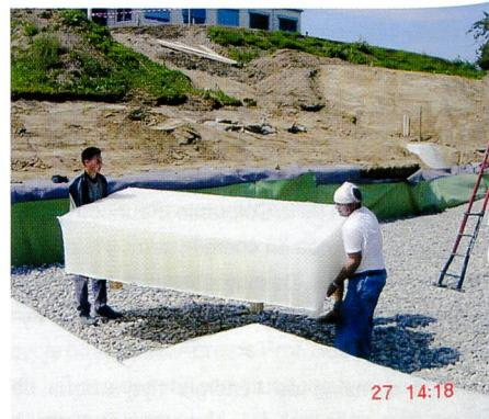
**Bild 2. Hauptkomponente des neuen Speichersystems sind die leichten, wabenförmigen und druckstabilen Nidaplast-Polyethylen-Kunststoffblöcke. 95% des Blockvolumens sind mit Wasser füllbar.**
