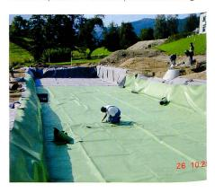
Bild 1. Kostengünstige Regenwasserspeicherung in einem unterirdisch angelegten Retentionsbecken: Mit dem neuen Nidaplast-Sarnafil-System ist beliebiges Retentionsvolumen relativ einfach herstellbar. Abgedichtet werden die Becken mit Sarnafil-Kunststoffbahnen.
