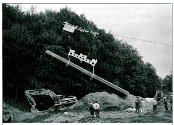
Transport und Versetzen Erdgasleitung, Rohrgewicht 12 Tonnen
