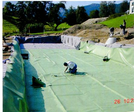
**Bild 1. Kostengünstige Regenwasserspeicherung in einem unterirdisch angelegten Retentionsbecken: Mit dem neuen Nidaplast-Sarnafil-System ist beliebiges Retentionsvolumen relativ einfach herstellbar. Abgedichtet werden die Becken mit Sarnafil-Kunststoffbahnen.**
