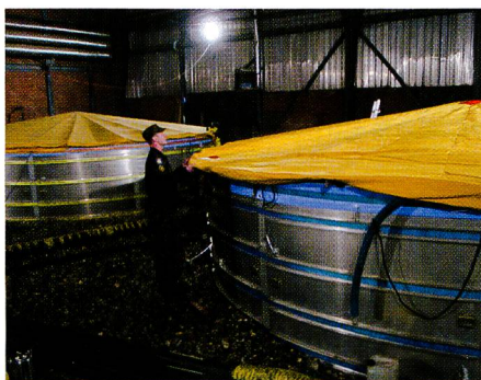
Bild 3. Die Lagerbecken zur Zwischenlagerung des Frischwassers.
