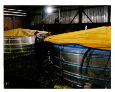
Bild 3. Die Lagerbecken zur Zwischenlagerung des Frischwassers.
