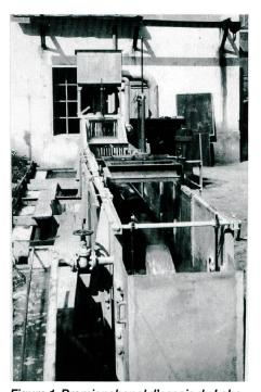
Figure 1. Premier chenal d'essais du Laboratoire d'hydraulique du génie civil, installé dans une cour des Ateliers de Constructions Mécaniques de Vevey (1928).
