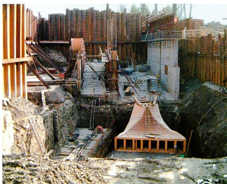
Bild 6. Bauzustand: Saugrohrschalung Hauptturbine.
