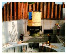
Bild 7. Montage Dotierturbine als Compacteinheit.
