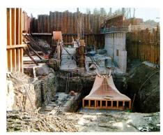
Bild 6. Bauzustand: Saugrohrschalung Hauptturbine.
