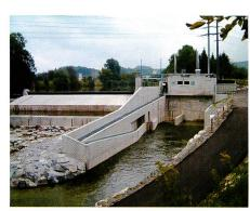
Bild 9. Ansicht von Unterwasser mit Fischaufstieg.
