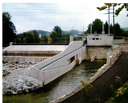
Bild 9. Ansicht von Unterwasser mit Fischaufstieg.
