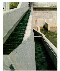
Bild 11. Betriebszustand mit 200 l/s Abflussmenge.
