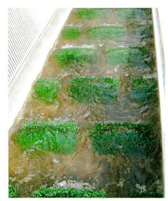
Bild 3. Abflussverhältnis in einem Borstenfischpass mit 8% Längsgefälle/200 l/s.
