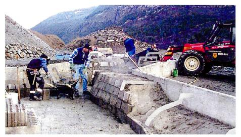
Bild 3. Modellierung der Felspartien mit Hilfe von PVC-Profilen in der Betonschale.
