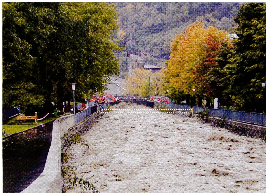
Bild 12. Blick in Fließrichtung in den Unterlauf des Saltinakanals auf der Höhe des Spitals. Die Stelle, wo der Fussgängersteg abgebrochen wurde, ist mit einer unterbrochenen weißen Linie markiert. Der Abfluss staute sich zweitweise und leicht an der verschalteten Festungswachtbrücke (Foto A. B.).
