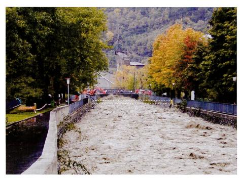
Bild 12. Blick in Fliessrichtung in den Unterlauf des Saltinakanals auf der Höhe des Spitals. Die Stelle, wo der Fussgängersteg abgebrochen wurde, ist mit einer unterbrochenen weissen Linie markiert. Der Abfluss staute sich zweitweise und leicht an der verschalten Festungswachtbrücke (Foto A. B.).
