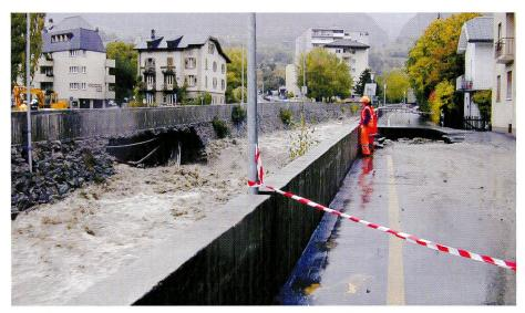
Bild 15. Einbrüche der Ufermauer bei einer Sperre am 15. Oktober 2000 (Foto A. B.).
