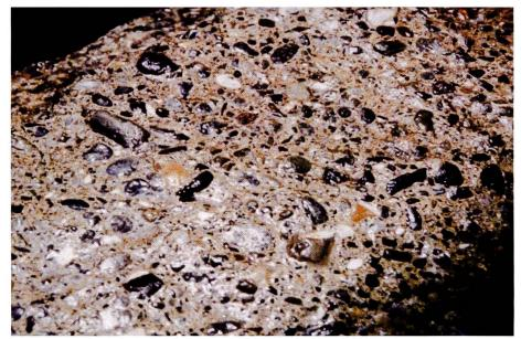
Bild 5. Oberflächlicher Verschleiss («Waschbeton») an Beton mit einem Grösstkorn von 32 mm an einer Wehrkrone.
