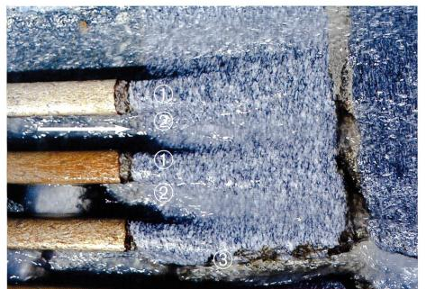
Bild 10. Abrasion von Naturstein durch Wasser hoher Fliessgeschwindigkeit und Geschiebe mit kleinem Durchmesser; im Strömungsschatten der Eisenbahnschienen ① ist die Abrasion geringer als dazwischen ②; in Strömungsrichtung unterhalb der Mörtelfugen ③ wird der Naturstein abradiert.
