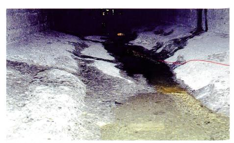
Bild 9. Schleifend und stossend beanspruchter Betonboden in einem Geschiebeumleitstollen mit wenig Schäden an den Wänden.
