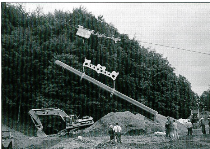
Transport und Versetzen Erdgasleitung, Rohrgewicht 12 Tonnen
