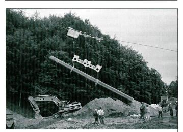
Transport und Versetzen Erdgasleitung, Rohrgewicht 12 Tonnen
