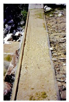
Bild 7. Muldenförmige Abrasion auf einem Wehrrücken.
