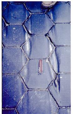
Bild 8. Linienförmige Abrasion in einem Gerinne mit Betonsohle (links) sowie abgeschliffener Schmelzbasalt (rechts).
