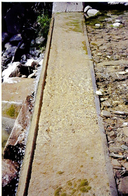
Bild 7. Muldenförmige Abrasion auf einem Wehrrücken.
