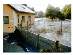
Bild 1. Hochwasser-Schutzsystem Talimex, praxisbewährt (Foto: FAG Austria AG, St. Veit).
