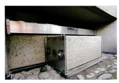
Bild 2. Lichtschacht und Fenster sicher geschützt mit Hochwasser-Schutzsystem Talimex.
