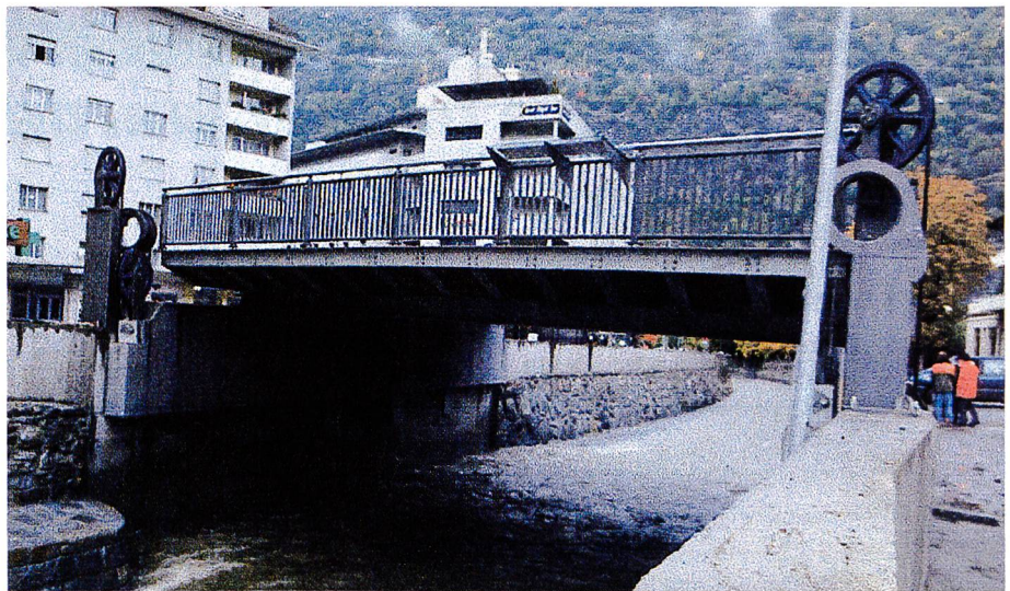
Bild 1. Hubbrücke über die Saltina in Brig-Glis in gehobenem Zustand (Aufnahme vom 17. Oktober 2000, zwei Tage nach dem Hochwasser).
