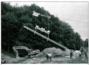
Transport und Versetzen Erdgasleitung, Rohrgewicht 12 Tonnen
