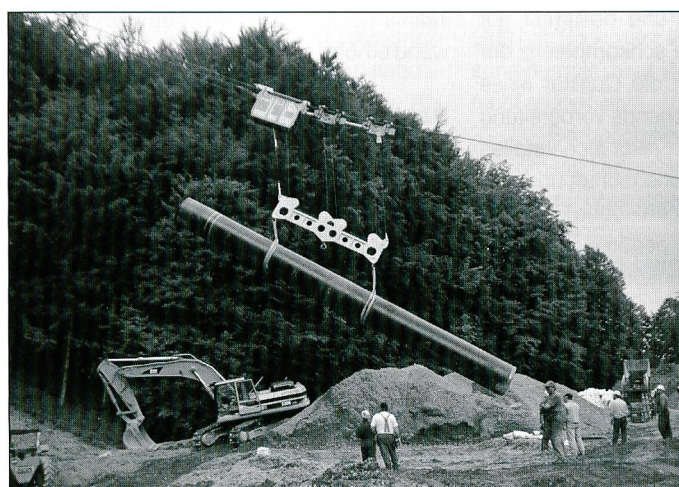
Transport und Versetzen Erdgasleitung, Rohrgewicht 12 Tonnen
