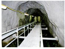
Bild 32. Entsanderkammer mit Bedienungssteg.
