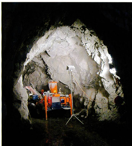
Bild 30. Ausbruchsarbeiten des Entsanders.
