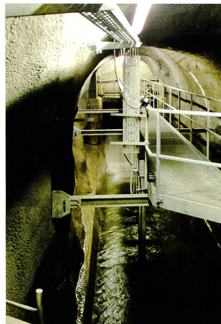
Bild 21. Entleerte Entsanderkammer mit Sand-Abtastsonde (Typ Schwingergabel).
