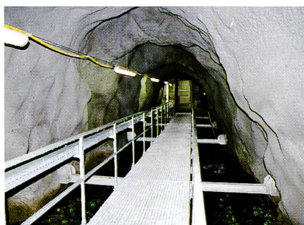
Bild 32. Entsanderkammer mit Bediensteg.
