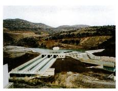
Bild 8. Wasserfassung KW Camlica I mit Stauwehr, Einlaufbauwerk, Entsander.
