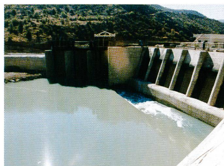
Bild 14. Spülkanal des Kiesabzugs vor dem Entsandereinlauf.
