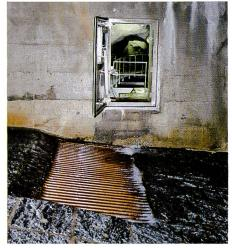
Bild 26. Tirolerfassung im Umleitstollen der Rovana. Einlaufrechen und Panzertüre in Richtung Entsanderkammer.
