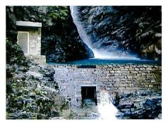
Bild 17. Festes Überfallwehr mit Spülschütze und Dotierauslass.
