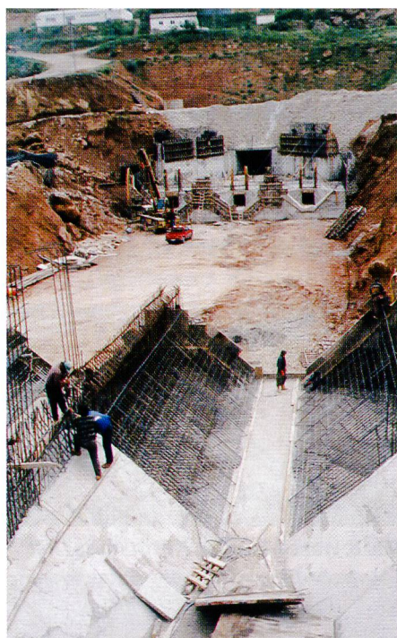
Bild 12. Entsander im Bau.
