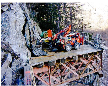
Bild 29. Bauplattform mit Bohrerjumbo für den Ausbruch der unterirdischen Entsanderkammer.
