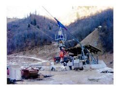
Bild 28. Talstation der Personen- und Materialseilbahn zur Erschliessung der Wasserfassung.
