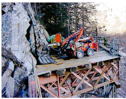
Bild 29. Bauplattform mit Bohrjumbo für den Ausbruch der unterirdischen Entsanderkammer.
