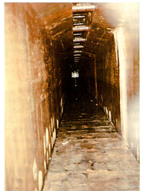
Bilder 5, 6 und 7. Beispiele einer Entsanderkammer mit vertikaler Spülung – Sandabzugvorrichtung Typ Bieri – Ansicht der Entsanderkammer, Sandabzugvorrichtung von oben und von unten (Spülkanal).
