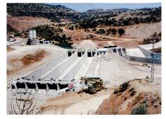
Bild 15. Übersicht über die drei Entsanderkammern im Bauzustand.
