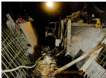
Bild 31. Spülkanal des Entsanders im Rohbau.
