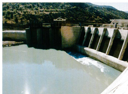
Bild 14. Spülkanal des Kiesabzugs vor dem Entsandereinlauf.
