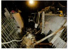
Bild 31. Spülkanal des Entsanders im Rohbau.
