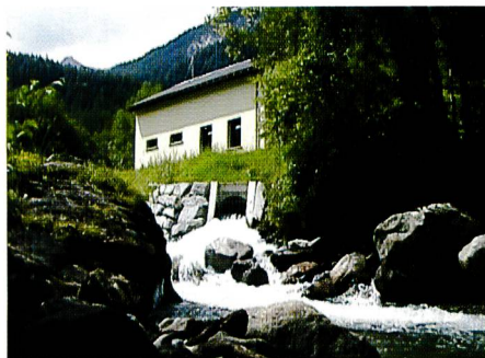
Bild 18. Unterwasser-Ansicht der Zentrale.
