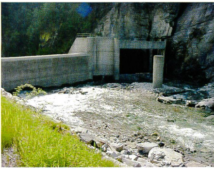
Bild 25. Fassung und Stolleneinlauf zum Umleitstollen der Rovana.
