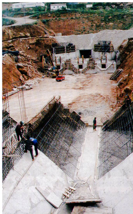
Bild 12. Entsander im Bau.
