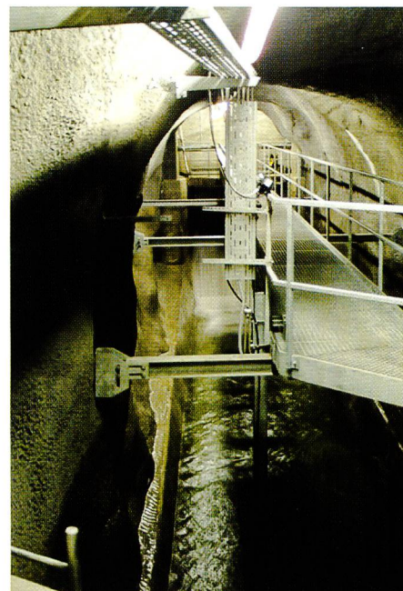
Bild 21. Entleerte Entsanderkammer mit Sand-Abtastsonde (Typ Schwingergabel).
