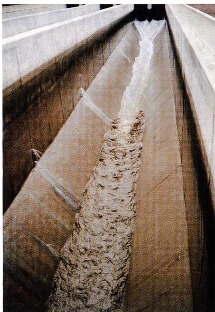
Bilder 3 und 4. Beispiele von zwei Entsanderkammern mit horizontaler Spülung.
