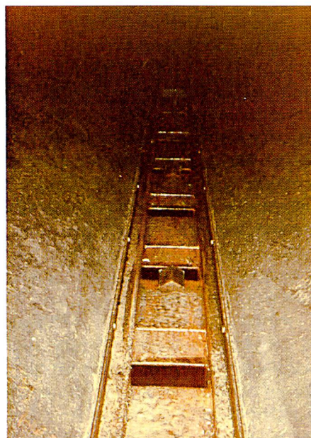
Bilder 5, 6 und 7. Beispiele einer Entsanderkammer mit vertikaler Spülung – Sandabzugvorrichtung Typ Bieri – Ansicht der Entsanderkammer, Sandabzugvorrichtung von oben und von unten (Spülkanal).
