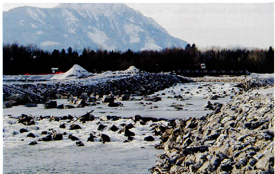
Bild 5. Die fertige Sohlrampe.
