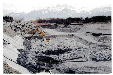
Bild 3. Bau der Sohlrampe in der neuen Illmündung.
