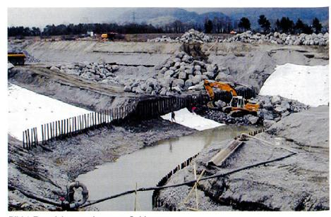
Bild 4. Fusssicherung der neuen Sohlrampe.
