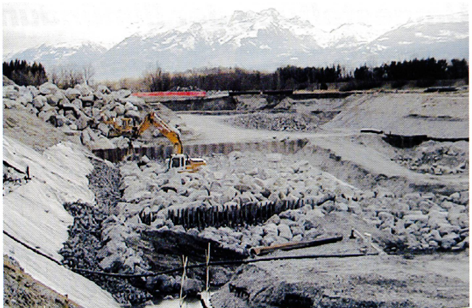
Bild 3. Bau der Sohlrampe in der neuen Illmündung.
