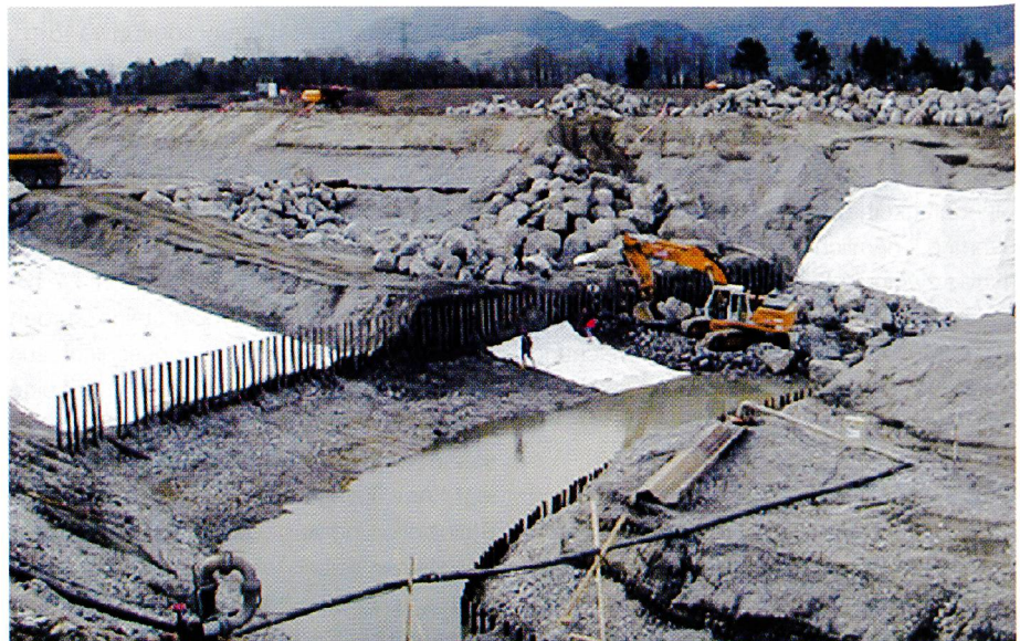
Bild 4. Fussssicherung der neuen Sohlrampe.
