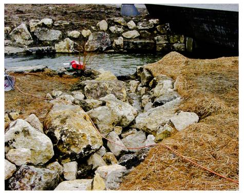
Bild 6. Der oberwasserseitige Ausstieg der Fischtreppe.
