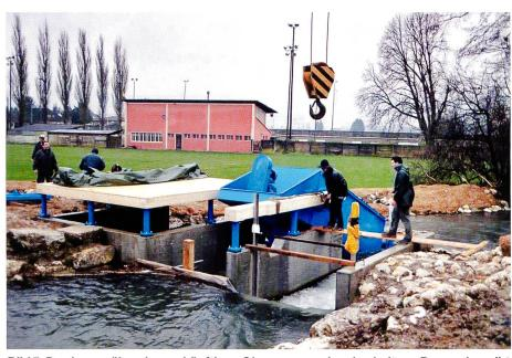
Bild 5. Das knapp über dem zukünftigen Oberwasserspiegel gehaltene Bauwerk ergibt eine lange Überfallkante.
