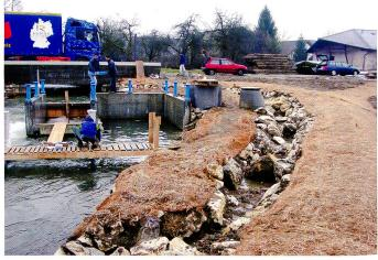
Bild 2. Das Kraftwerk: links der Umgehungskanal, mittiger Triebwasserkanal, rechts der Überlauf und die Fischtreppe. Der Auflagewinkel der Schnecke wird mit einer Holzlehre korrekt positioniert (Bild rechts).
