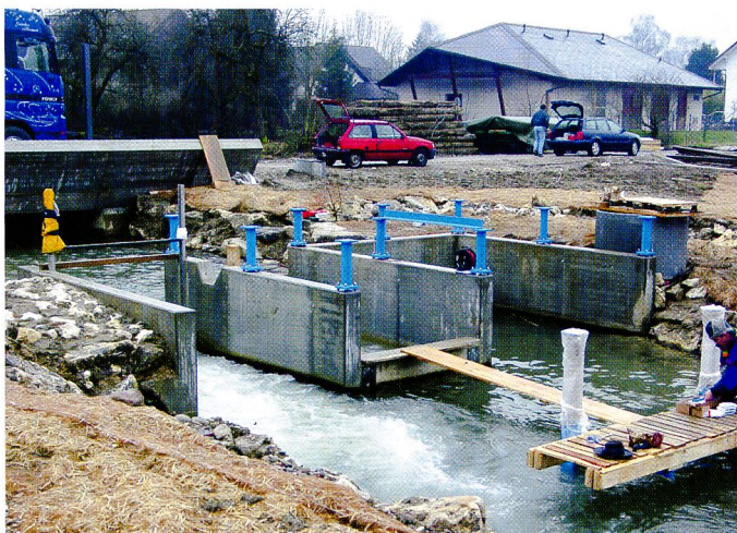
Bild 2. Das Kraftwerk: links der Umgehungs kanal, mittlerer Triebwasserkanal, rechts der Überlauf und die Fischtreppe. Der Aufstellungswinkel der Schnecke wird mit einer Holzlehre korrekt positioniert (Bild rechts).
