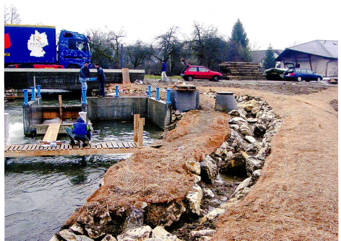
Bild 2. Das Kraftwerk: links der Umgehungs kanal, mittlerer Triebwasserkanal, rechts der Überlauf und die Fischtreppe. Der Aufstellungswinkel der Schnecke wird mit einer Holzlehre korrekt positioniert (Bild rechts).
