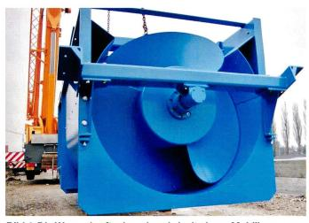
Bild 4. Die Wasserkraftschnecke wird mit einem Mobilkran zum Einsatzort gehoben.
