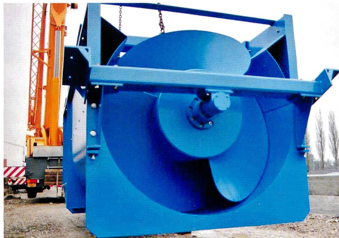
Bild 4. Die Wasserkraftschnecke wird mit einem Mobilkran zum Einsatzort gehoben.
