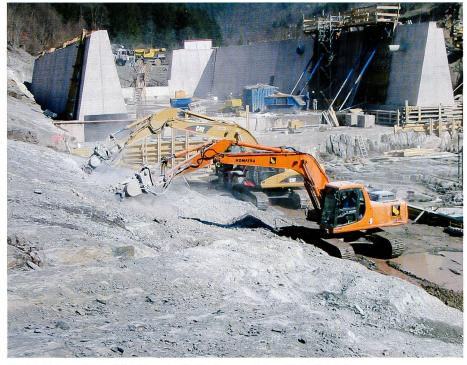
Bild 2. Felsaushub dicht über der Gründungssohle mittels Felsfräsen.
