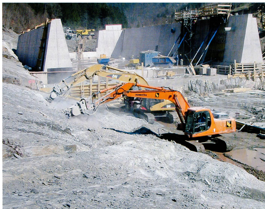
Bild 2. Felsaushub dicht über der Gründungssohle mittels Felsfräsen.
