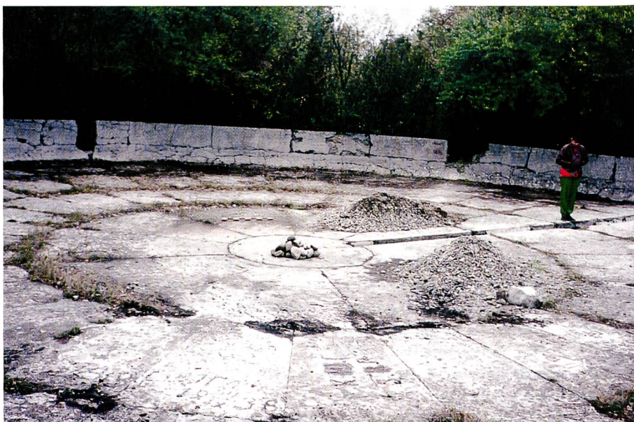
Bild 2. Überreste eines Taubrunnens von F. Zibold in Feodosia (Krim) aus der Zeit um 1900. Durchmesser 20 m, Höhe 8 m. Foto: D. Beysens, Archiv OPUR.
