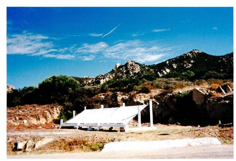
Bild 5. Taukollektor in Vignola, bei Ajaccio, Korsika. Die Kollektorfläche beträgt 30 m², die Ausbeute erreicht bis zu 11,8 Liter Wasser im Tag. Foto: D. Beysens, Archiv OPUR.
