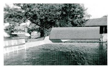
Bild 8. Seitenwehr – Fotomontage einer Variante mit Segmentklappenschütze.
