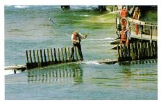
Bild 4. Manuelles Versetzen der Holznadeln beim Stirnnadelwehr.
