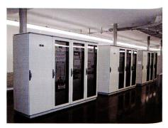
Bild 6. Leittechnik und Vorortsteuerung für Maschinen Nr. 1–3.
