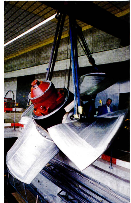
Bild 3. Neues Turbinenlaufrad bei der Montage.
