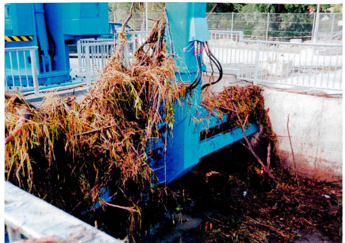
Bild 5. Greiferharke schliesst sich über der Wasseroberfläche.
