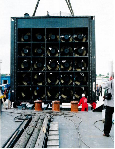
Bild 8. HYDROMATRIX®-Modul Schiffsschleuse Freudenau.
