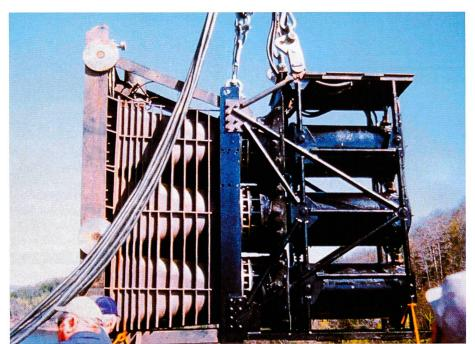
Bild 6. Colebrook-Modul während der Installation.
