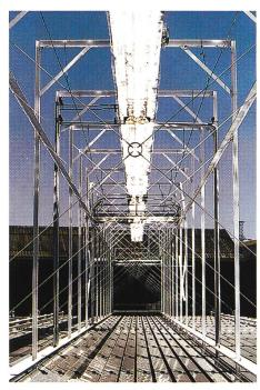
Die wie eine Fresnel-Linse aufgefächerten Spiegel – unten im Bild – reflektieren die Sonnenstrahlen auf die oben liegende Absorberröhre. Die Pilotanlage im belgischen Liège hat eine Reflektorfläche von 2500 m². (Foto: Solarmundo)
