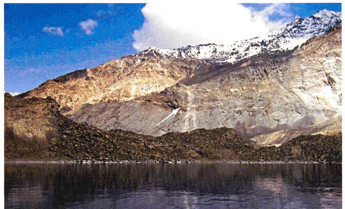
Bild 3. Usoi-Damm und Lake Sarez, welcher 1911 während eines starken Erdbebens in Tajikistan durch einen Fels- und Gletscherabbruch gebildet wurde. Klar erkennbar ist die Anrissstelle des Felssturzgebietes am rechten Ufer (maximale Dammhöhe ca. 650 m; Freibord ca. 50 m; Volumen des Felssturzdammes ca. 2 km 3 ).
