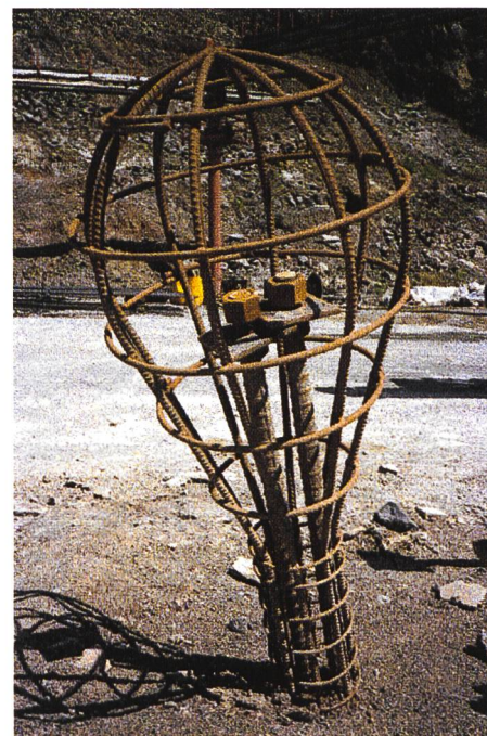
Bild 1. Bewehrungskorb zur Verbesserung der Krafteinleitung von der Stau-mauer in den Felsnagel (Egger, EPFL).
