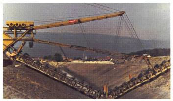
Bild 4. Aushub des Seebodenkanals, Gampelen, Eimerkettenbagger, 1976.
