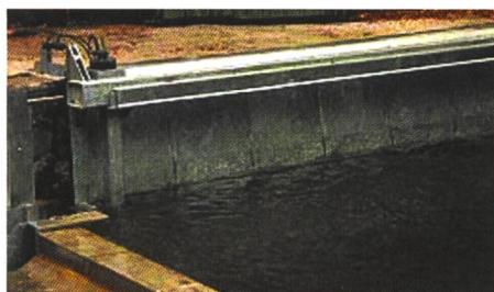
Bild 6. Horizontale Rechenreinigungsmaschine: Bei kleinen Rechen mit Abschwemmmöglichkeit stellt diese eine einfache Gesamtlösung dar.
