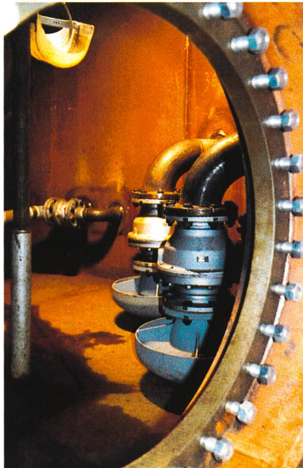
Innenliegender Tank-Kugelhahn.
