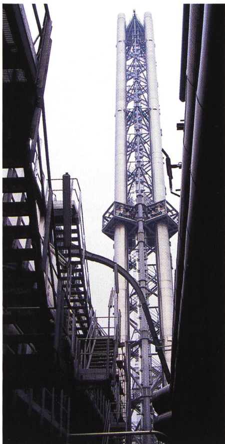
Bild 4. Rauchgasreinigung mit 80 m hohem Kamin.
