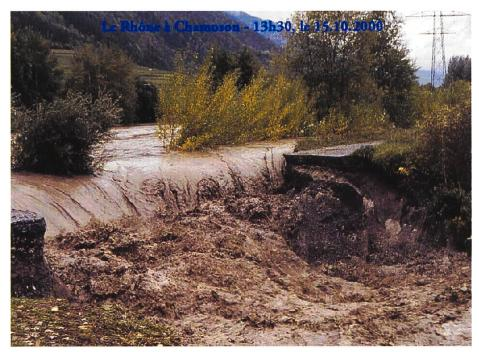
Figure 1. Rupture de la digue du Rhône à Chamoson le 15 octobre 2000.
