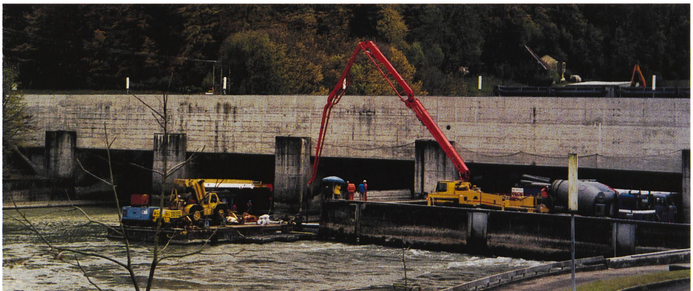
Bild 3. Die Betonierinstallationen im Unterwasser.
