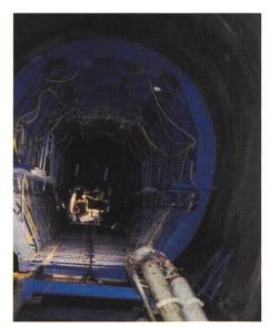
Figure 8. Coffrage télescopique.
