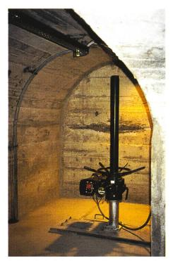
Bild 4. Beispiel einer elektromechanisch angetriebenen Schütze.
