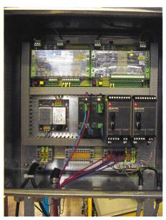
Bild 7. Stahlgehäuse mit Speisung, Signalschutz, Feldbus-Modulen und -LWL-Modems.
