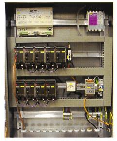
Bild 9. Hier als Beispiel das DVM 1957 mit Versorgung, Riflex-Station und den LWL-Modems für Feldbus und V24.
