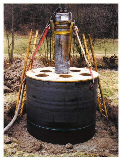
Bild 2. Der Terra-Hammer TR 540 rammt mit zwei bis drei Schlägen pro Sekunde und einer Schlagkraft von 2200 Tonnen das Rohr mit Ø 2,5 m Zentimeter für Zentimeter in das Erdreich.
