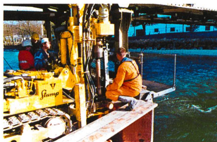
Bild 8. Vom Ponton aus werden in der Strömung Mikropfähle gebohrt (Brücke über die Reuss bei Gnadenthal).
