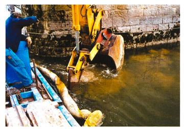
Bild 6. Entscheidend für die Wirkung des Kolkschutzes ist die Qualität der Ausführung. Die Blöcke werden unter Wasser einzeln versetzt (Aarebrücke bei Koblenz).
