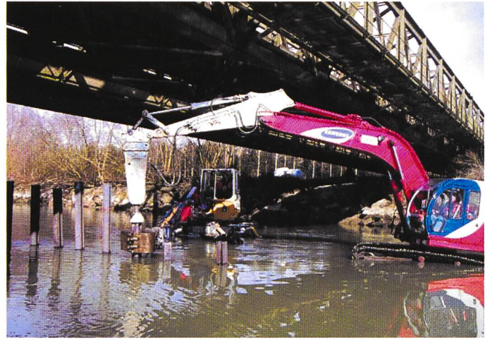
Bild 7. Rammen von Eisenbahnschienen in der Strömung (Thurbrücke bei Müllheim).
