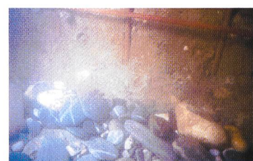
Bild 4. Bei einer Tauchinspektion können Unterkolkung wie auch Schäden am Bauteil festgestellt werden: freigelegte Armierung im Kolkloch einer nur siebenjährigen Brücke im Rhein.
