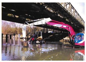
Bild 7. Rammen von Eisenbahnschienen in der Strömung (Thurbrücke bei Müllheim).
