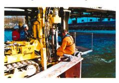
Bild 8. Vom Ponton aus werden in der Strömung Mikropfähle gebohrt (Brücke über die Reuss bei Gnadenthal).
