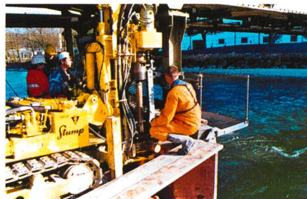
Bild 8. Vom Ponton aus werden in der Strömung Mikropfähle gebohrt (Brücke über die Reuss bei Gnadenthal).
