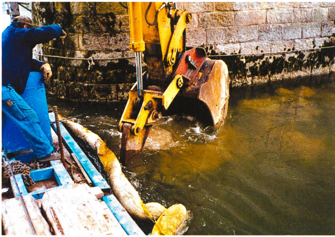
Bild 6. Entscheidend für die Wirkung des Kolksschutzes ist die Qualität der Ausführung. Die Blöcke werden unter Wasser einzeln versetzt (Aarebrücke bei Koblenz).
