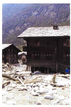
Bild 4. Im Dorfbereich von Täsch wurden durch den Murgang vom 21. Juni 2001 rund 15000 m³ Material abgelagert. 38 Wohnhäuser wurden beschädigt. Ein Haus musste abgerissen werden (Bildquelle: Teysseire und Candolfi AG).
