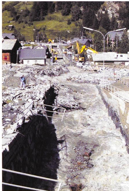
Bild 3. Der Murgang vom 21. Juni 2001 hinterliess in Täsch grosse Schäden an der Gemeindeinfrastruktur. In Mitleidenschaft gezogen wurden Brücken, Verkehrswege, Strassen, Wasserversorgung, Elektrizität und Kanalisation (Bildquelle: Teyssiere und Candolfi AG).
