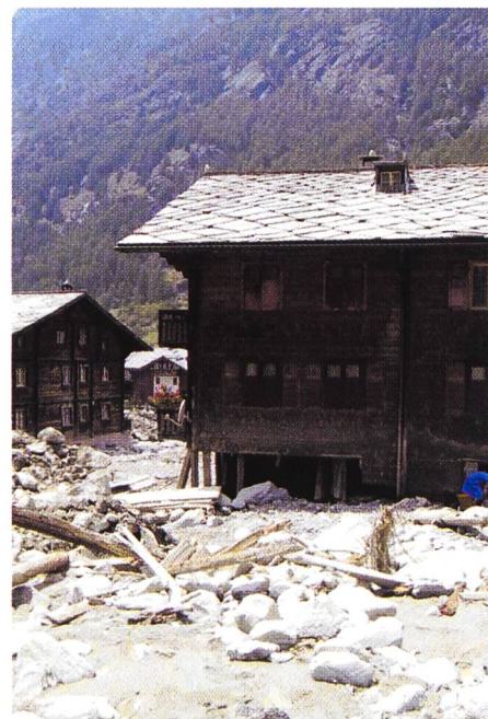
Bild 4. Im Dorfbereich von Täsch wurden durch den Murgang vom 21. Juni 2001 rund 15000 m 3 Material abgelagert. 38 Wohnhäuser wurden beschädigt. Ein Haus musste abgerissen werden (Bildquelle: Teyssiere und Candolfi AG).
