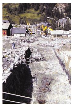
Bild 3. Der Murgang vom 21. Juni 2001 hinterliess in Täsch grosse Schäden an der Gemeindeinfrastruktur. In Mitleidenschaft gezogen wurden Brücken, Verkehrswege, Strassen, Wasserversorgung, Elektrizität und Kanalisation (Bildquelle: Teysseire und Candolfi AG).
