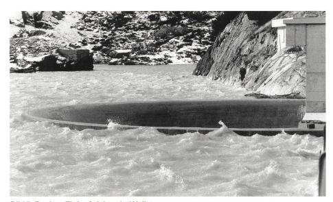
Bild 5. Fertiger Einlauftrichter bei Vollstau.
