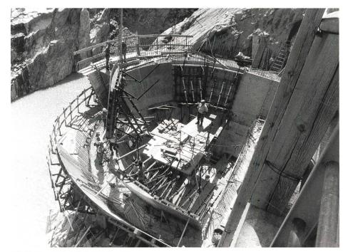
Bild 3. Der Einlauftrichter im Bau.
