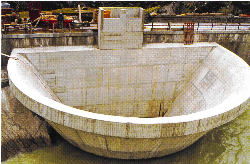
Umbau der Hochwasserentlastungsanlage Räterichsboden der KW Oberhasli
