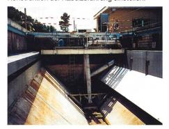
Diese Situation traf auch auf die Abwasserreinigungsanlage Sarneraatal in Alpnach (OW) zu. Die stark V-förmige Beckengeometrie – ursprünglich ein Konzept, um ohne Räumer auszukommen, was sich jedoch als unrealistisch erwies – liess nur eine ungenügende Räumung zu. Zudem stiess die Rücklaufschlammförderung mit den bestehenden statischen Hebern häufig an ihre Grenzen.
