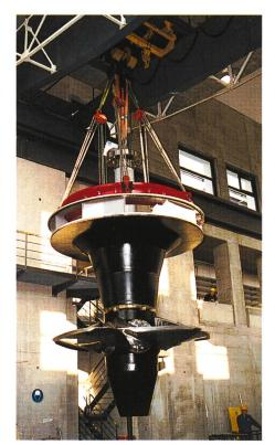
Bild B7-1. Einfahren und Montage der Turbine Gruppe 3. Die mit dem Maschinensaalkran versetzte Turbine mit einem Laufraddurchmesser von 3,60 m und fünf Schaufeln ist mit dem Turbinendeckel und der Turbinenwelle 34 Tonnen schwer.
