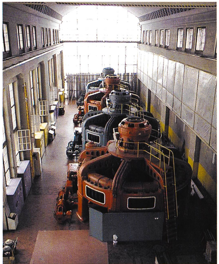
Bild B3-1. Die noch in Betrieb stehenden alten Maschinengruppen mussten während der Umbauphase vor Staub und vor grösseren Erschütterungen geschützt werden. Bild links: Blick vom neuen Maschinensaalboden in Richtung der Staub- und Trümmerschutzwand, hinter welcher die alten Maschinengruppen noch voll in Betrieb sind. Bild rechts: Die Strom produzierenden alten Maschinen- gruppen 1 bis 4 mit der Staubschutzwand im Hintergrund.
