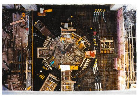
Bild B6-11. Blick auf die Decke der Einlaufspirale vor dem Betonieren.
