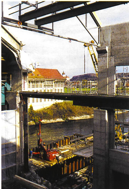
Bild B6-10. Montage der provisorischen Kranbahn.
