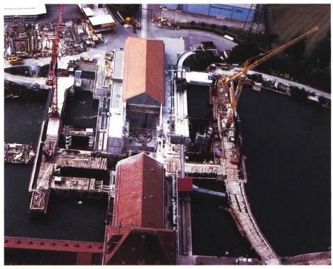
Bild B6-6. Luftaufnahme Ende 2. Bauetappe/Beginn 3. Bauetappe mit den Uminstallationsarbeiten der Baugruben im OW und UW.
