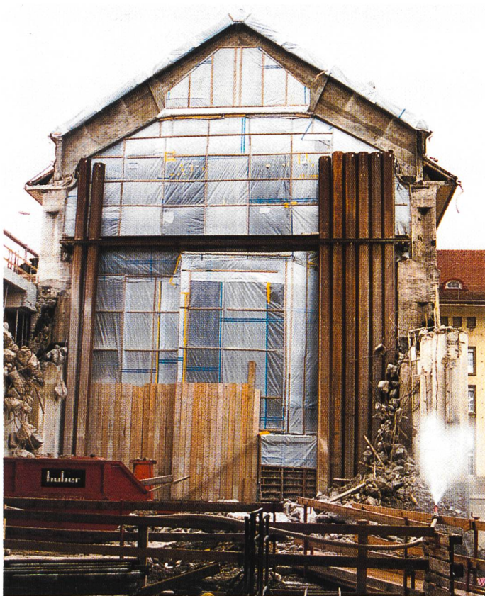
Bild B3-1. Die noch in Betrieb stehenden alten Maschinengruppen mussten während der Umbauphase vor Staub und vor grösseren Erschütterungen geschützt werden. Bild links: Blick vom neuen Maschinensaalboden in Richtung der Staub- und Trümmerschutzwand, hinter welcher die alten Maschinengruppen noch voll in Betrieb sind. Bild rechts: Die Strom produzierenden alten Maschinen- gruppen 1 bis 4 mit der Staubschutzwand im Hintergrund.
