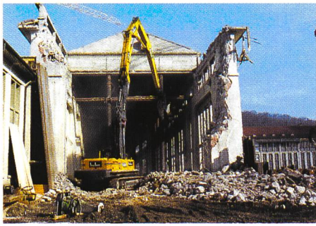
Bild B6-9. Betonabbruch während der 1. Bauetappe.
