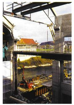
Bild B6-10. Montage der provisorischen Kranbahn.
