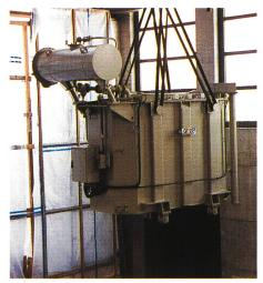
Bild B8-1. Einbringen eines Maschinentransformators in die Transformatorzelle mit Hilfe des Maschinensaalkranes.
