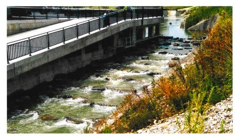
Bild A8-9. Abflusskontrollbauwerk des Umgehungsgewässers, ungeregelte Blocksteinrampe und mit einem Drehtor regelbarer Kanal (unter der Abfahrt).
