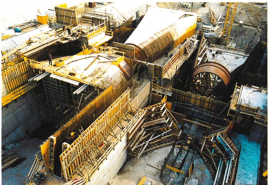
Bild A4-7. Rohbau: Spezialschalungen für Einläufe und Saugrohre in verschiedenen Erstellungsphasen.
