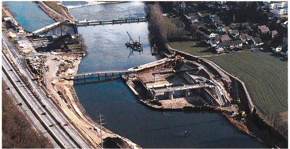
Bild A4-3. Baugrube Phase 1.
