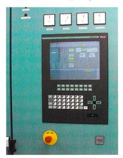
Bild A6-3. Bedienstelle im Maschinenleitstand.
