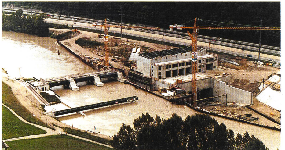
Bild A4-5. Baugrube Phase 2.
