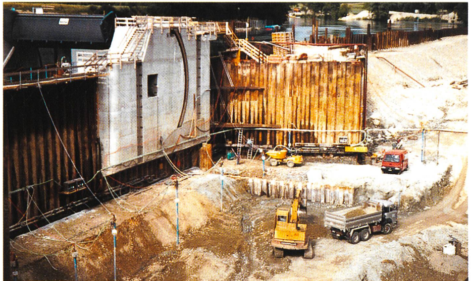
Bild A4-4. Phasengrenze Baugrube 1 zu Baugrube 2.
