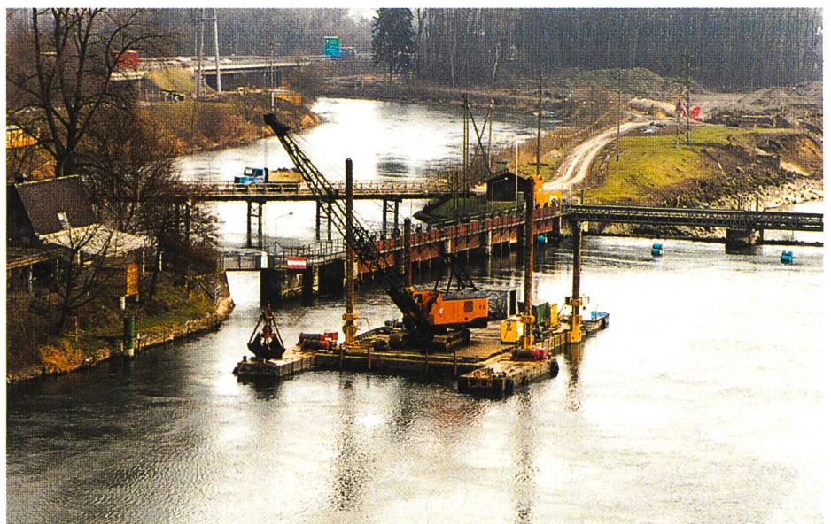
Bild A4-10. Baggerungen in der Aare.
