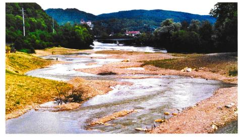
Bild A8-7. Unterer Abschnitt des strukturreichen Umgehungsgewässers bei einem Abfluss von 5,0 m³/s mit Stromschnellen, Kiesbänken, Gewässerverzweigung.
