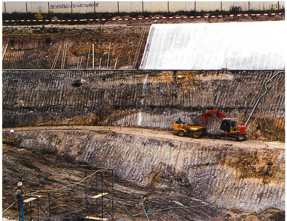
Bild A2-2. Aufnahme der Baugrube für das Maschinenhaus, im Oktober 1998: Hangseitige Böschung im lehmigen Randbereich, im Vordergrund Vakuumfilterbrunnen.
