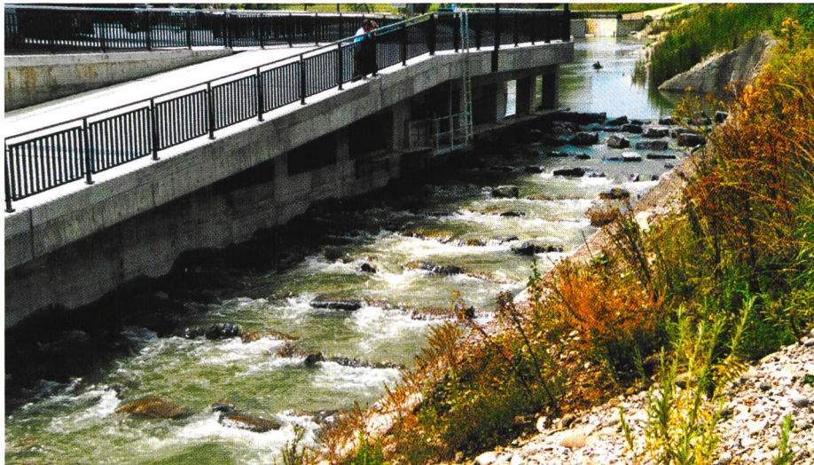
Bild A8-9. Abflusskontrollbauwerk des Umgebungsgewässers, unregelmäßige Blocksteinrampe und mit einem Drehtor regelbarer Kanal (unter der Abfahrt).
