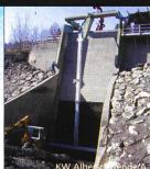
**Neu:** Hydraulische Rechenreinigungsanlagen bis 20 m Tiefe
