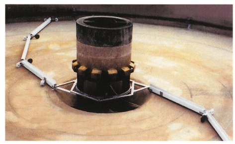
Bild 2. Ansicht eines Unterwasser-Schlammräumers mit zwei Räumschilden.
