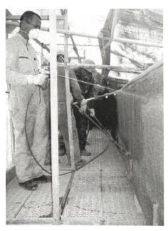
Bild 2. Maschinelle Applikation durch Spritzen.
