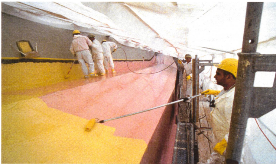
Bild 3. Maschinelle Applikation direkt ab Roller.
