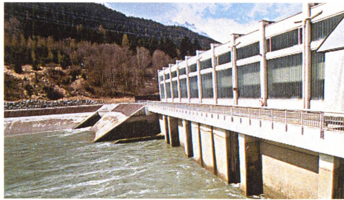
Bild 10. Abdichtung einer eingestauten Aussenwand einer Kraftwerkzentrale.
