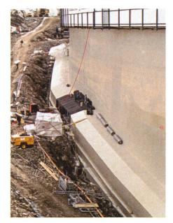
Bild 9. Abdichtung einer Talsperre inkl. Sohlgang auf 2200 m ü.M.
