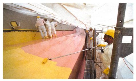
Bild 3. Maschinelle Applikation direkt ab Roller.
