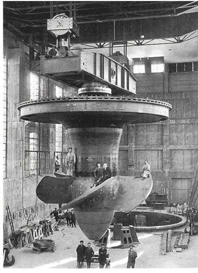
Bild 2. Montage der Kaplan-Laufräder.
