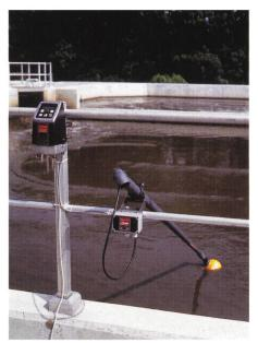
Bild 3. Am Geländer des Belebungsbeckens ist ein Evita-Oxy-Messumformer sowie ein PVC-Rohr mit Schwimmerkugel und eingebautem Sauerstoffsensor angebracht. Die Messgenauigkeit beträgt 0,5% vom Messbereichs-Endwert (Werkfoto: Danfoss AG).
