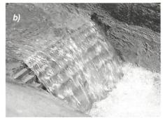
Bild 8. Absturzbauwerk bei a)  $Q = 0.2 \text{ m}^3/\text{s}$ , b)  $Q = 3.0 \text{ m}^3/\text{s}$ .
