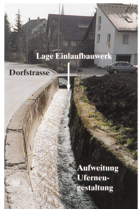
Bild 3. Blick in Fließrichtung des Dorfbaches Spreitenbach im Ist-Zustand auf die künftige Lage des Einlaufbauwerkes. Im Zuge der hochwassersicheren Umgestaltung werden das Gewässer wo möglich aufgeweitet und die Ufer mit Böschungen und Bepflanzung naturnah gestaltet.
