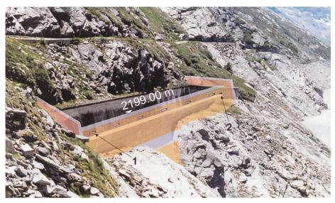
Bild 8. Speicher Mattmark – Erhöhung der Hochwasserentlastung.
