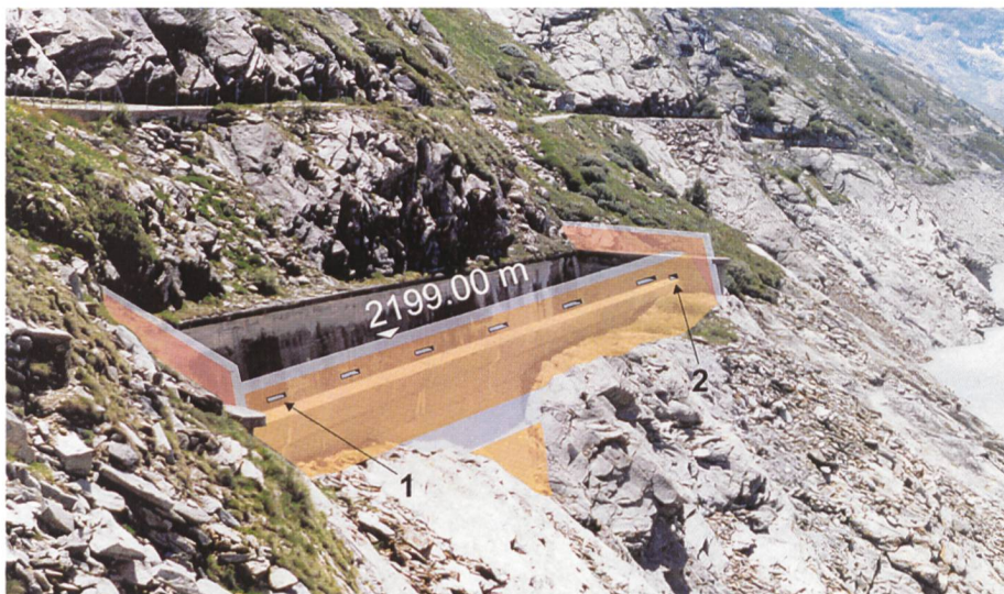
Bild 8. Speicher Mattmark – Erhöhung der Hochwasserentlastung.
