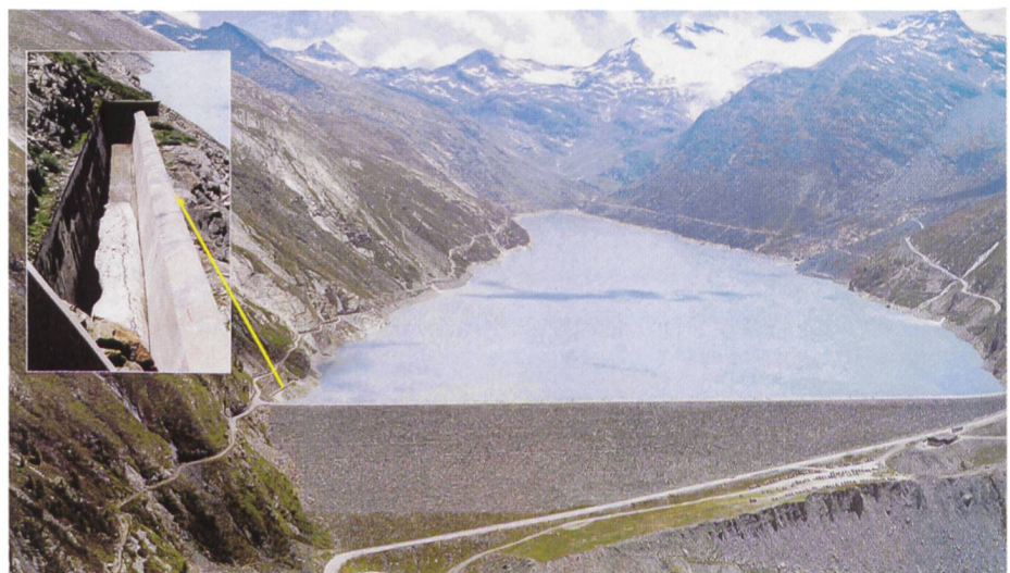
Bild 3. Stauanlage Mattmark mit Hochwasserentlastung. Nutzinhalt: 100 Mio. m 3 \Delta 331 GWh, max. Stauhöhe 2197 m ü.M.
