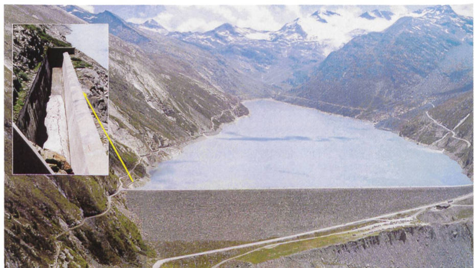
Bild 3. Stauanlage Mattmark mit Hochwasserentlastung. Nutzinhalt: 100 Mio. m³ △ 331 GWh, max. Stauhöhe 2197 m ü.M.
